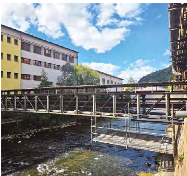
Od začiatku septembra panoval na moste čulý ruch, pričom viacero prác bolo realizovaných aj zo zaveseného lešenia priamo nad riekou Hron.
