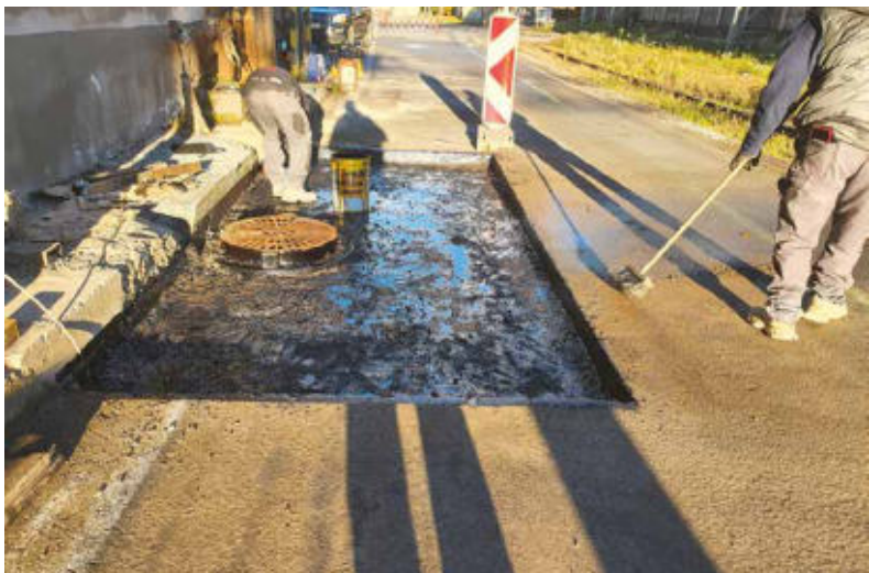
V uplynulých dňoch bolo realizované asfaltovanie opravovaného miesta.
