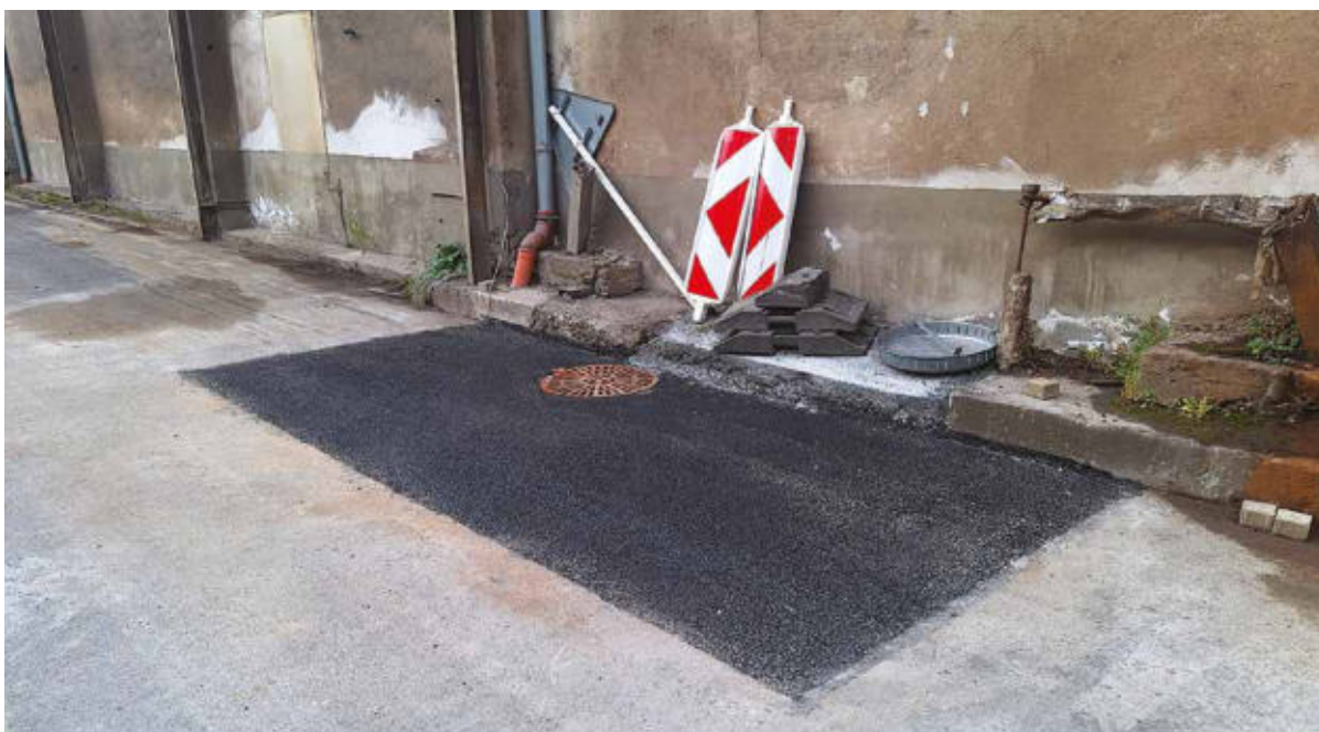
Výkop je už zaasfaltovaný a úsek prejazdny bez obmedzení.
