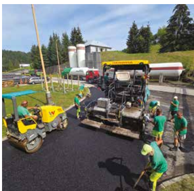
Na snímke hore príprava pred asfaltovaním, na dolnej samotné asfaltovanie.
