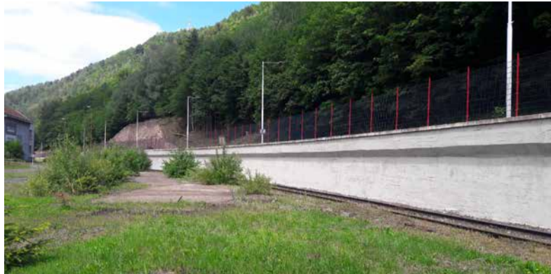
Oporný múr popod štátnu cestu I/66. V uplynulých dňoch na ňom externá firma vykonala ochranný náter. Foto: P. Krajan
