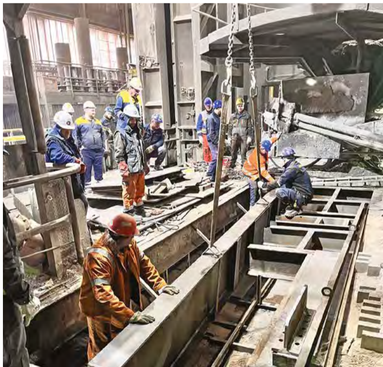
Výmena nosníka podlahy pece EAF. Foto: D. Nosál
