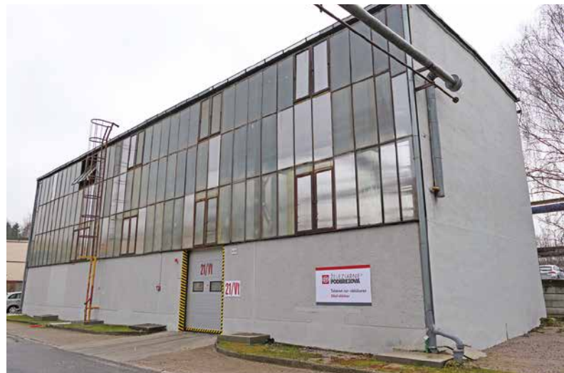
Budova skladu oblúkov v areáli nového závodu.
