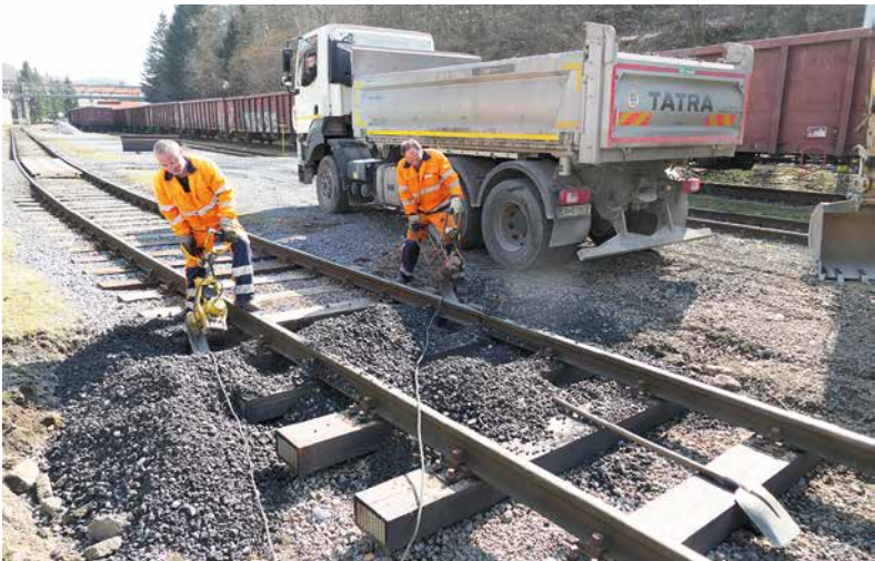
Zamestnanci dopravy, strediska údržby dopravných ciest a tratí, vykonávajú na základe pravidelných prehliadok výmenu drevených podvalov na miestach, kde sú už staré podvaly opotrebované a napadnuté hnilobou. Po výmene podvalov a zmontovaní koľaje je dosypané štrkové lôžko a vykonaná ručná strojová a výšková úprava koľaje podbíjaním. Foto: T. Kubej
