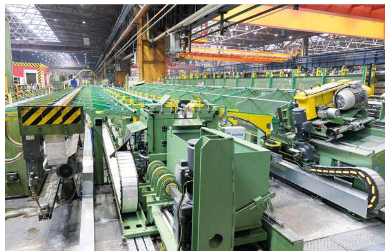
Úpravárenská linka rúr v prevádzkarni ťaháreň rúr.
