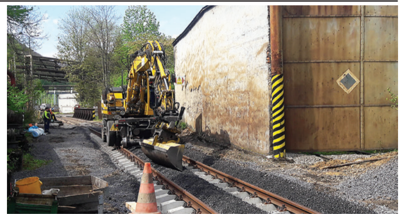
Mechanizmus LIEBHERR 900 pri tvarovaní a úprave štrkového lôžka z umelého hutného kameniva.
