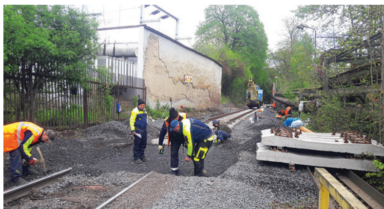
Zamestnanci Koľajových a dopravných stavieb s.r.o. Košice pri pokládke a montovaní poslednej časti koľaje na opravovanom úseku.
