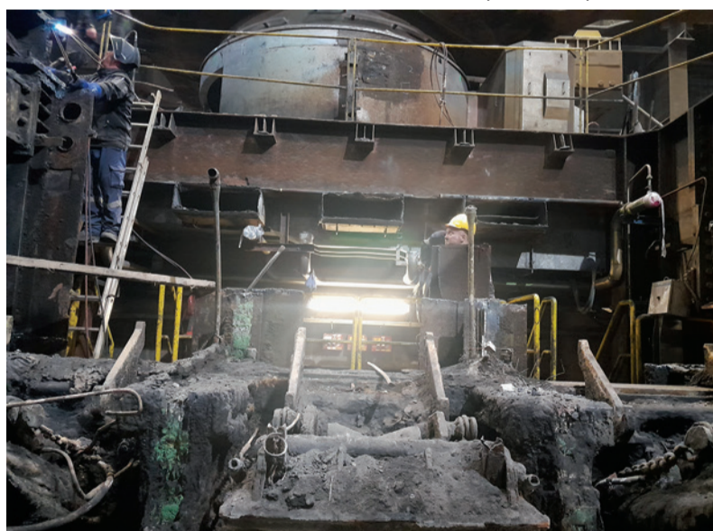
Demontáž pôvodnej sekundárnej komory ZPO.
