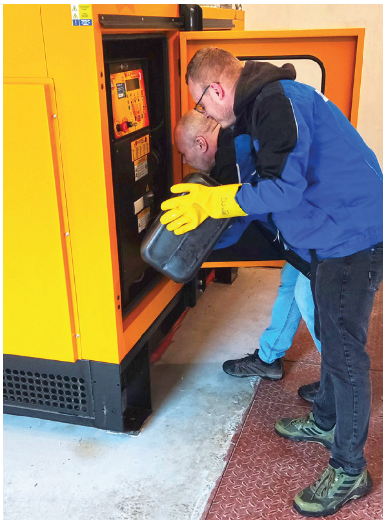
Údržba motorgenerátora – dopĺňanie paliva.
