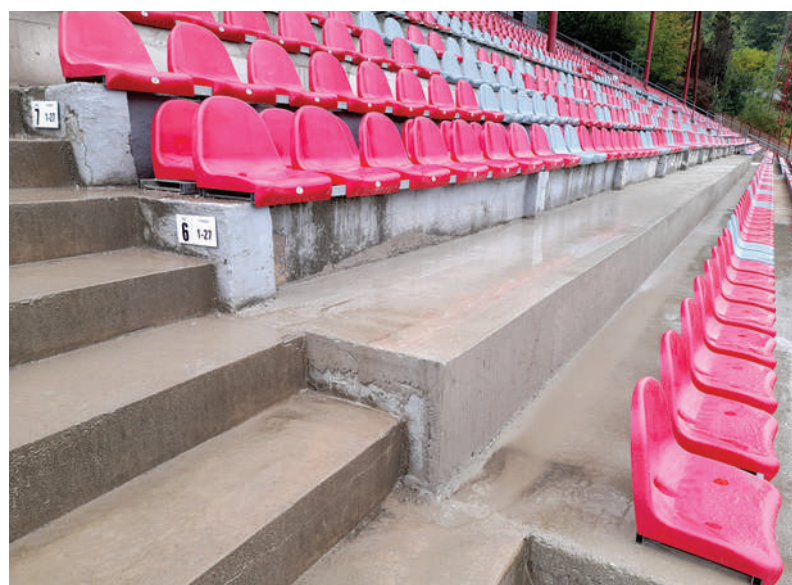
Na južnej tribúne pribudli opravené betónové stupne.
