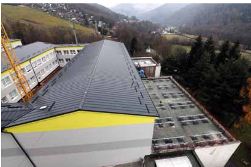
Budovy dostali nové sedlové strechy. Na snímke vpravo namontovaná konštrukcia na solárne panely. Foto: J. Čieľ
