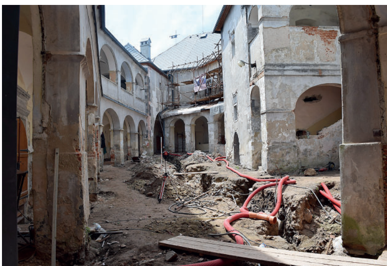
Stav horného nádvorja počas realizácie nového odvodnenia.
