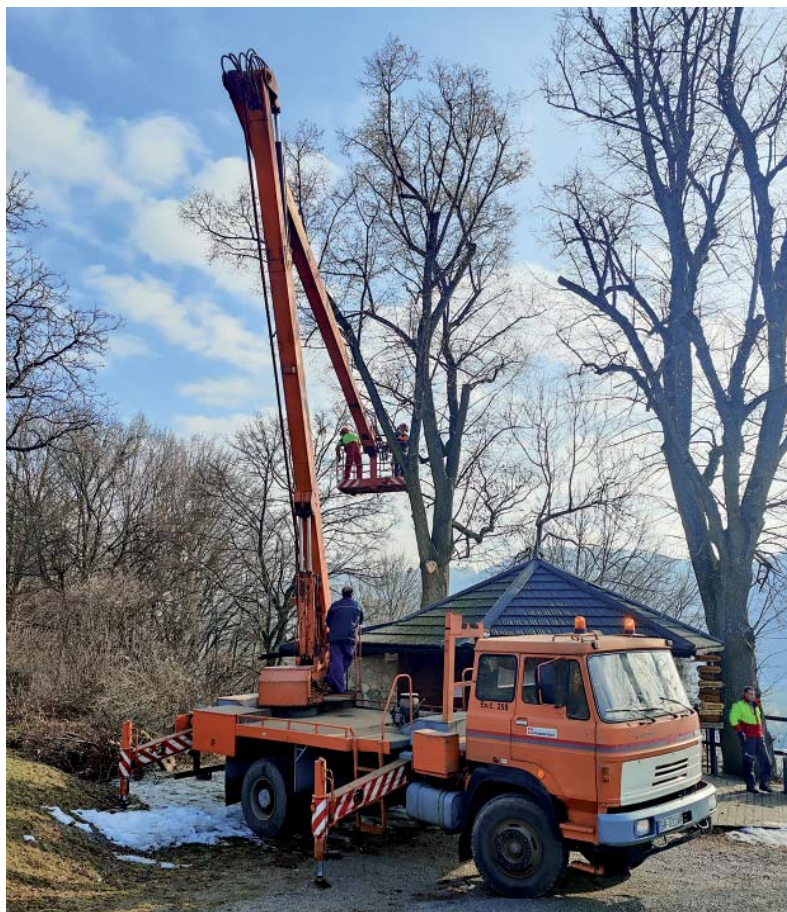
Na lipe pred vstupom do hradu Ľupča bola na báze kmeňa lokalizovaná nebezpečná drevokazná huba uhliarík pálený. Následná akustická tomografia skonštatovala masívne poškodenie koreňového systému, s vysokým rizikom vylomenia kmeňa. Kvôli ohrození stability a zlému zdravotnému stavu dreviny sa realizoval jej riadený výrub.
