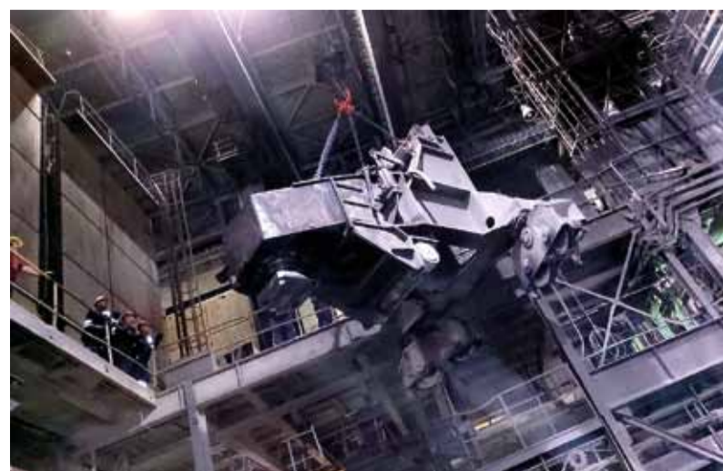
Prevoz horizontálnej konštrukcie otoče portálu pece EAF po výmene ložiska. Foto: P. Gernic
