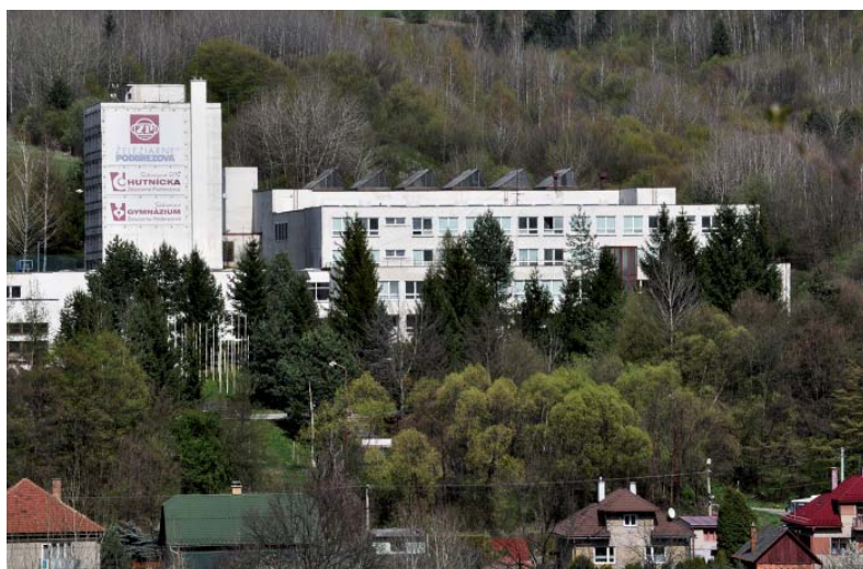
Súčasný pohľad na budovu Súkromnej spojenej školy Železiarne Podbrezová. Foto: J. Čieľ
