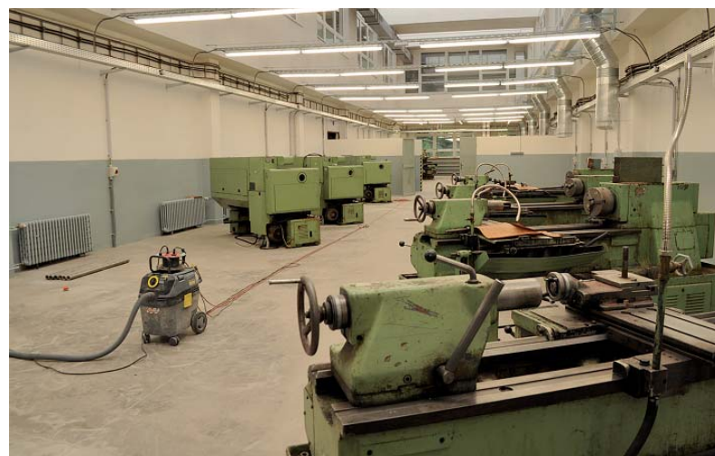
V novom školskom roku otvoria zrekonštruované sústružnícke a tesárske dielne. F: J. Čieľ
