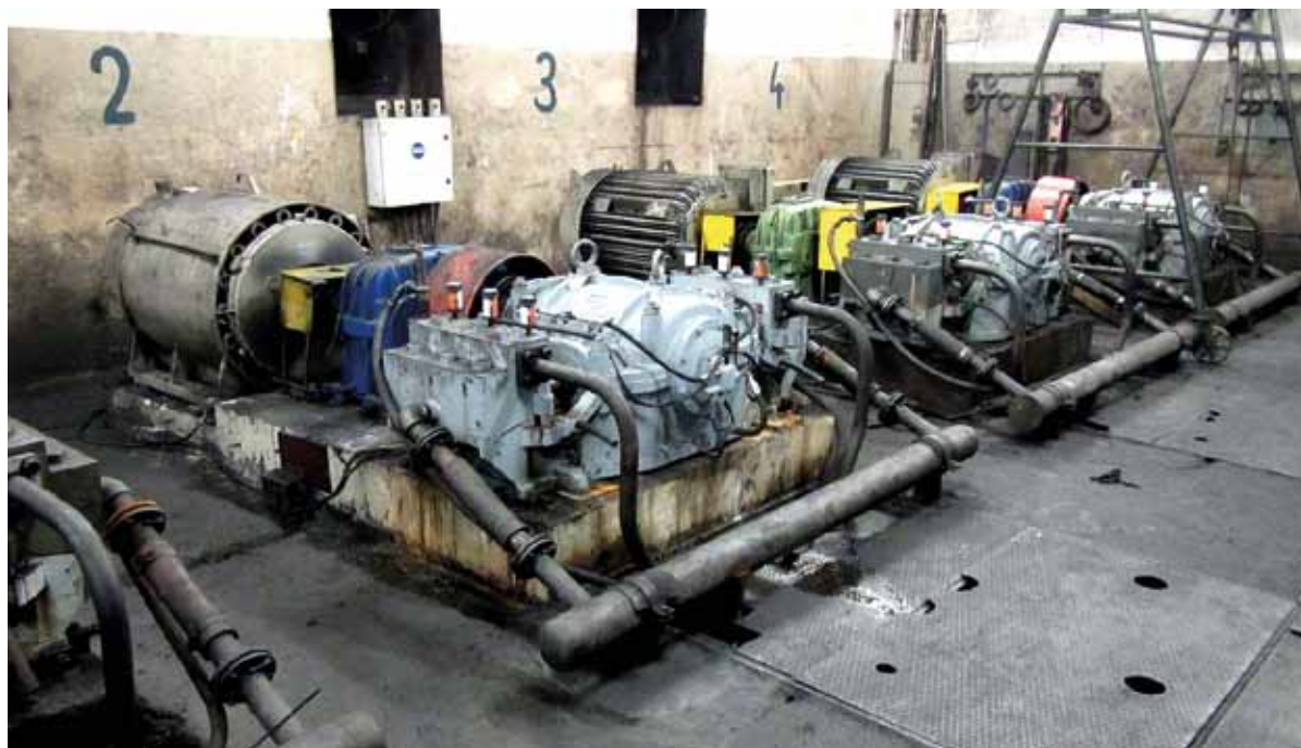
Pohľad na vymenené čerpadlo č. 2 v akustanici tlakovej vody
