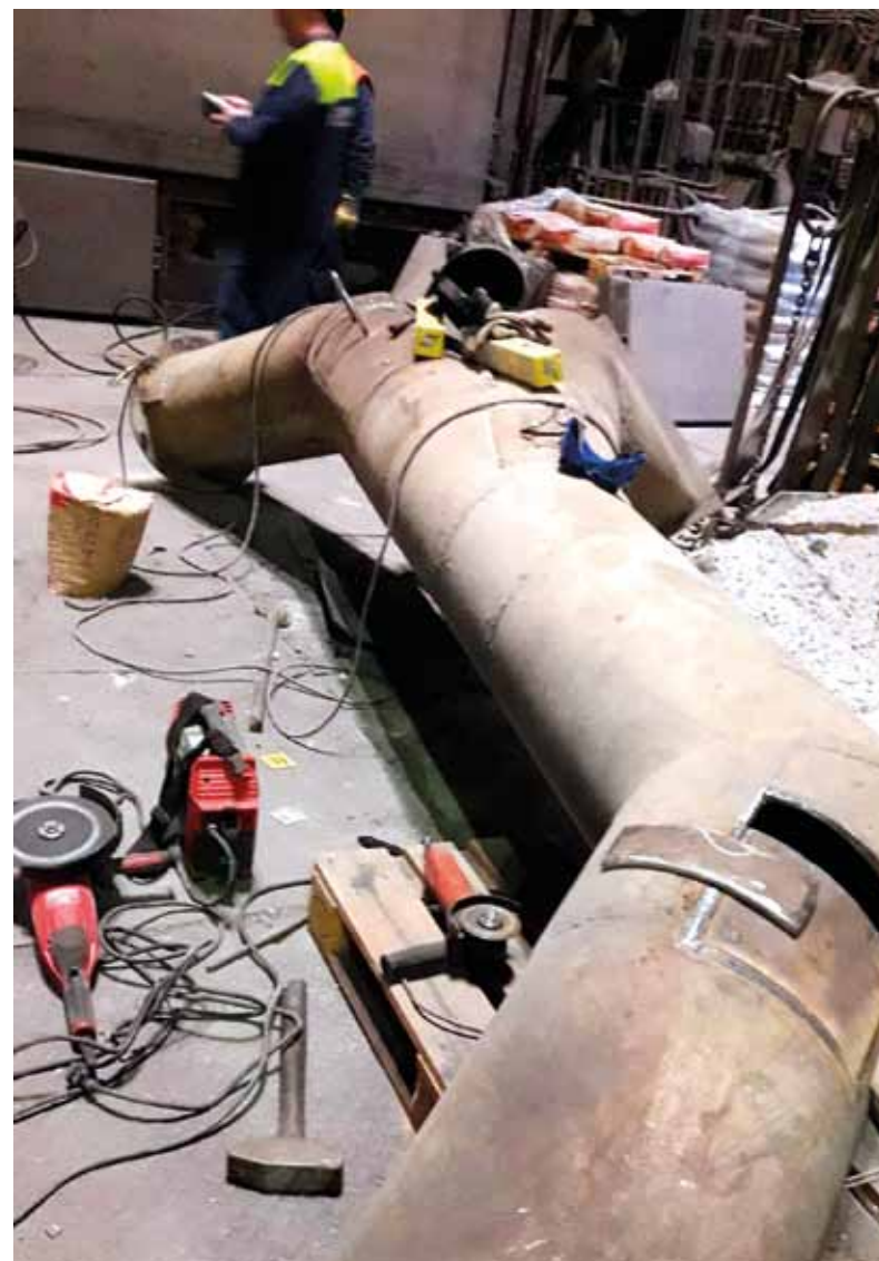
Oprava násypky prísad do panvy
