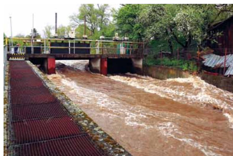
Situácia na hati v malej vodnej elektrárni Predajná po výdatných dažďoch.
