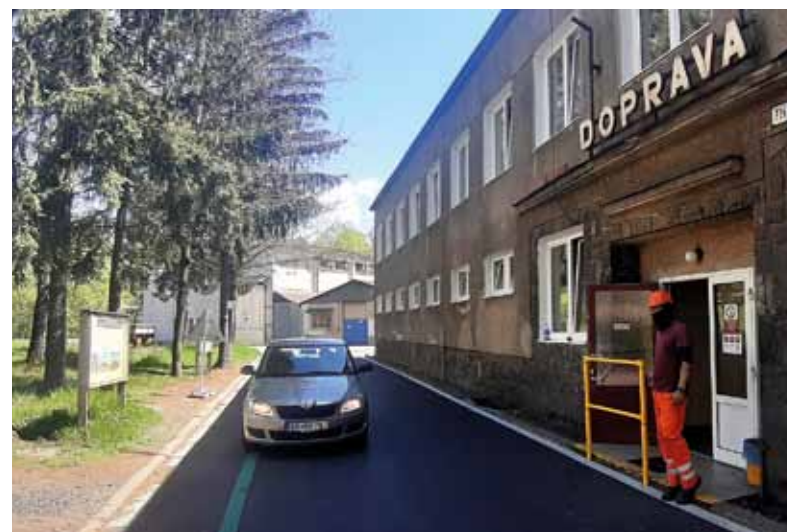
V priestore pred vstupom do budovy železničnej dopravy v starom závode môže dôjsť ku kolízii s chodcami, prechádzajte pozdĺž nej so zníženou rýchlosťou. Foto: M. Jančovič
