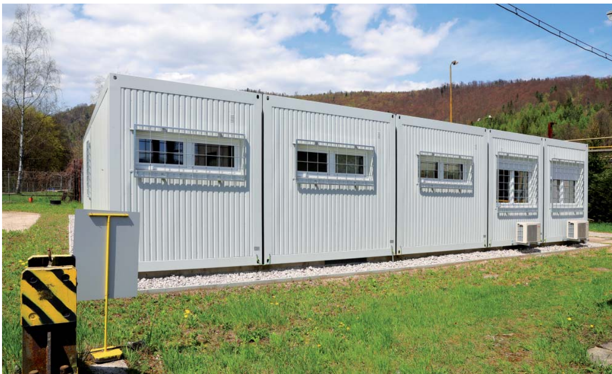
Novovytvorená administratívna budova v prevádzkarni oceliaren objektívom A. Nociarovej
