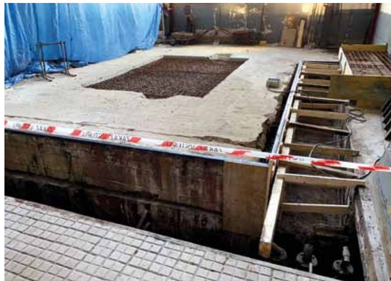
Príprava základu pod nový kotol K7 v teplárni nového závodu
