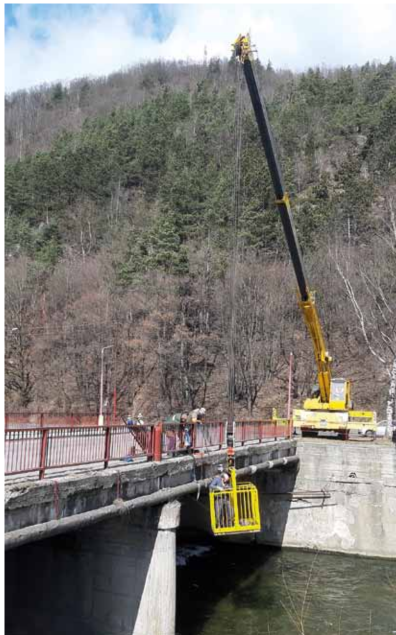
Autožeriav AD 28 prevádzkarne doprava s montážnym košom zabezpečuje a umožňuje zamestnancom údržby prevádzkarne energetika vykonať na moste ponad Hron opravu opotrebovaných konzol držiacych vodovodné potrubie, napájajúce sídlisko Kolkáreň.
