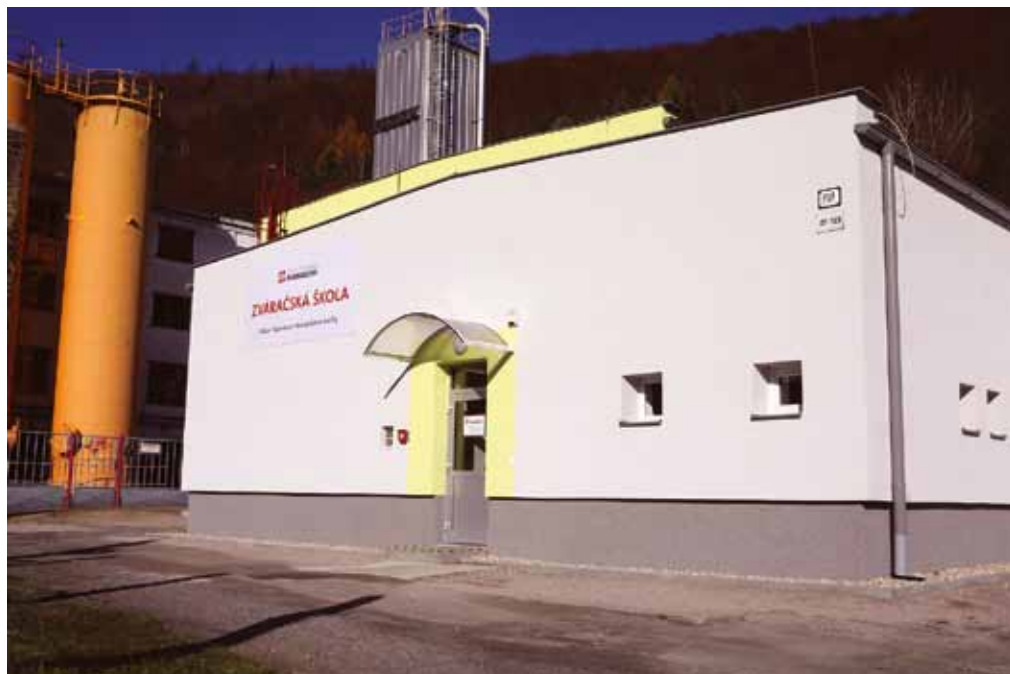
Zváračská škola ŽP objektívom I. Kardhordovej
