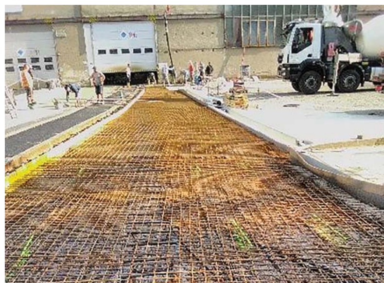
Odstavná plocha počas realizácii opravy
