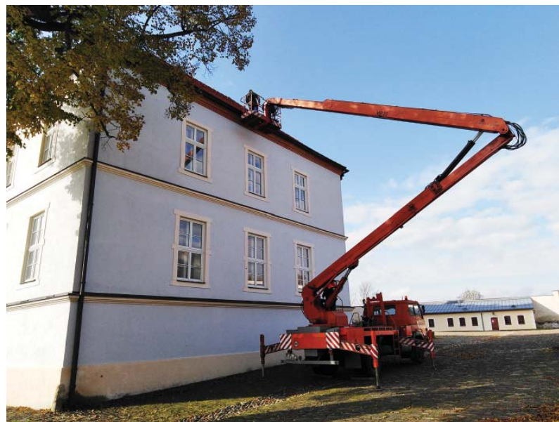
Čistenie zvodov a žľabov za pomoci plošiny z prevádzkarne doprava objektívom I. Uhlík
