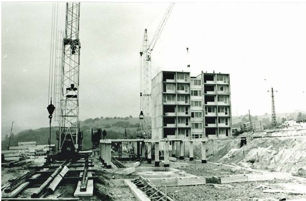
Pohľad na výstavbu prvej etapy SOU hutníckeho v Lopeji.
