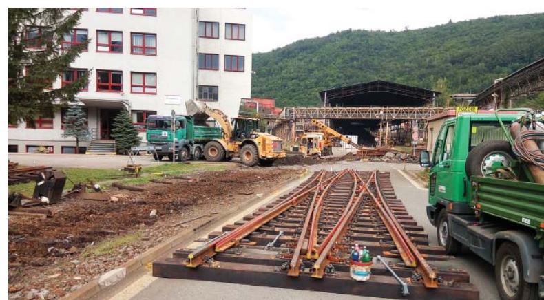
Odstránenie starého železničného lôžka
