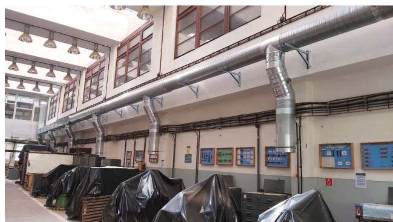
Rekonštrukcia vzduchotechniky a rozvodov tepla
