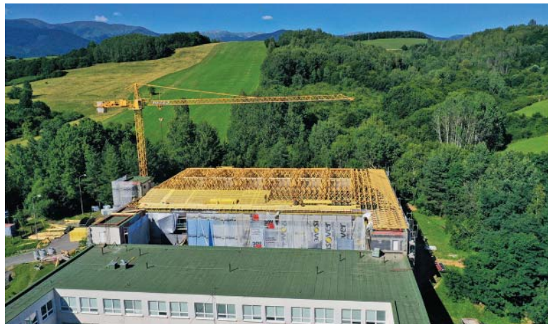
Rekonštrukcia strechy na budove školy
