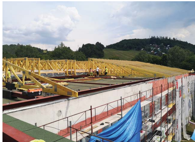
Cez leto bola zrealizovaná kompletná rekonštrukcia strechy
