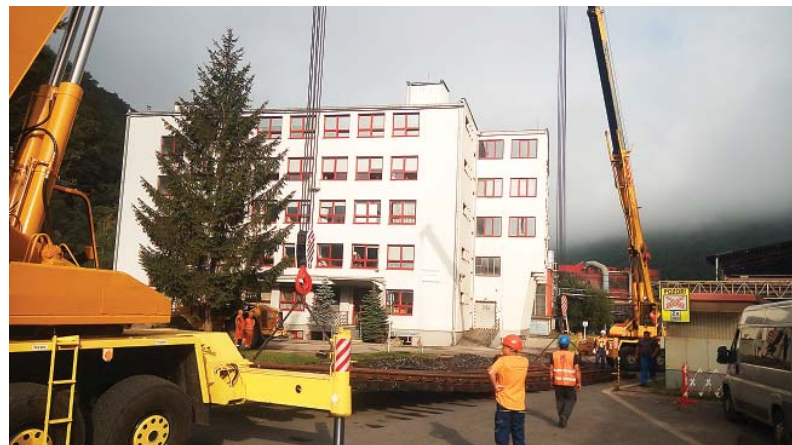
Pokládka výhybky č. 34ab
