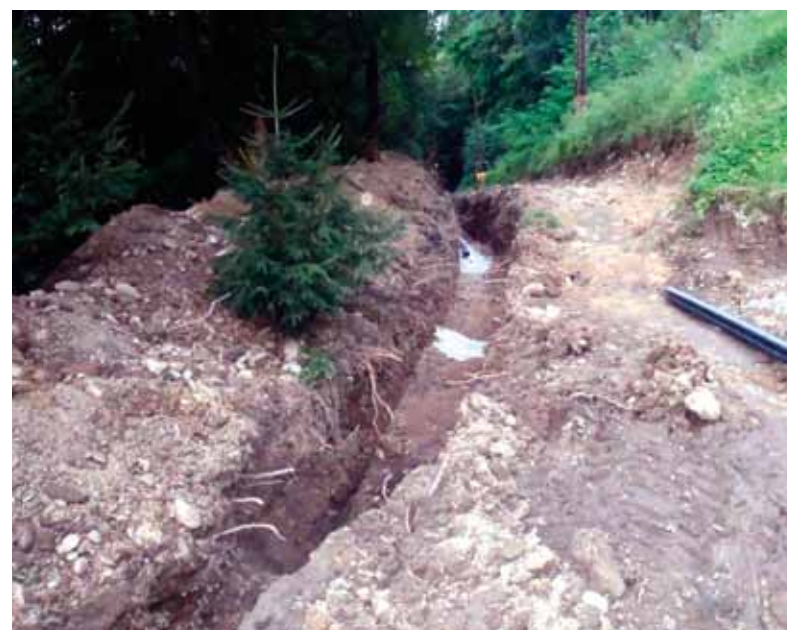
Pokládka potrubia úžitkovej vody
