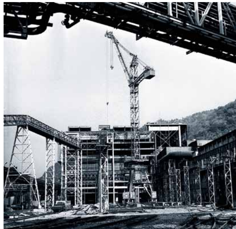
Celkový pohľad na výstavbu haly oceliarne objektívom A. Nociarovej
