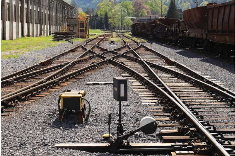
Výhybky 41, 42, 43 a 44 zapojené do sústavy dvojitej koľajovej súpravy. Foto: I. Kardhordová
