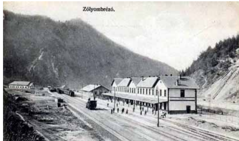
Prvá železničná stanica v Podbrezovej bola vybudovaná v čase stavby trate Banská Bystrica – Podbrezová, v roku 1883. Foto: archív redakcie
