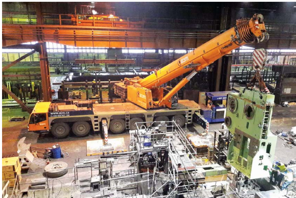
Pohľad na umiestnenie nového stojana nožnice Lindemann 2200 MP na základ
