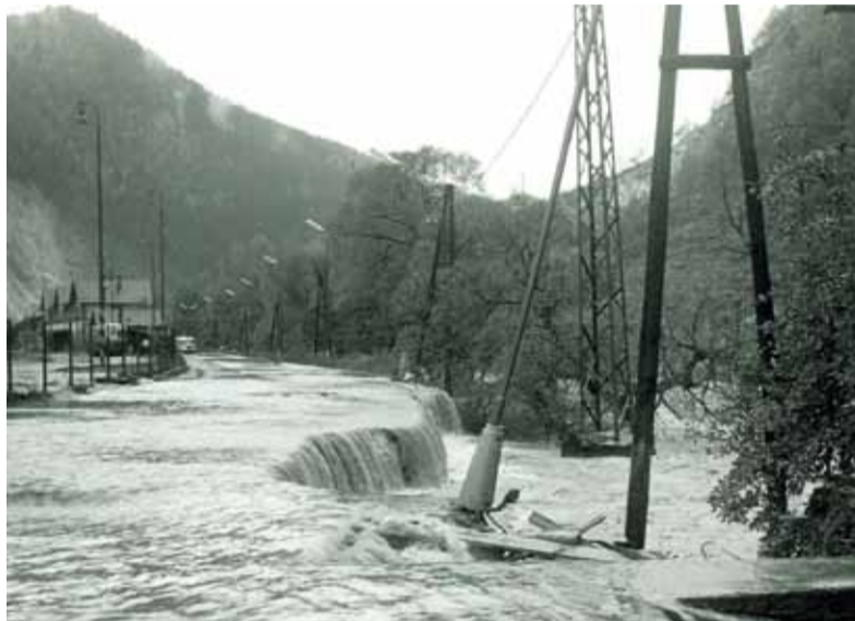
Zatopená cesta na železničnú stanicu v Podbrezovej.
