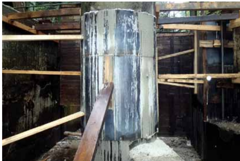
HC Jasenie – oprava betónových pilierov v hati Lomnistá
