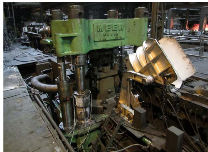
Pohľad na zabudovaný nový dierovací lis pri ukončovacích prácach
