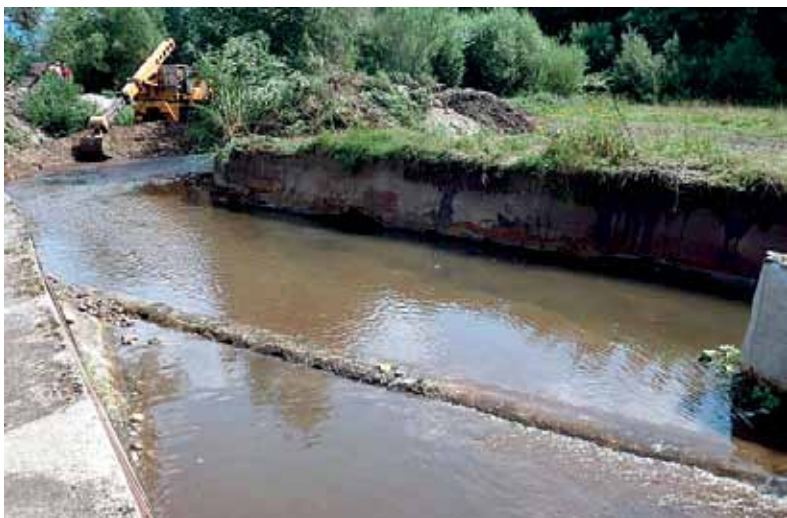
Čistenie vtokového zariadenia hať Štiavnička od nánosov piesku.
