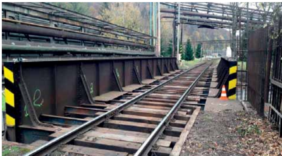
Most pred opravou
