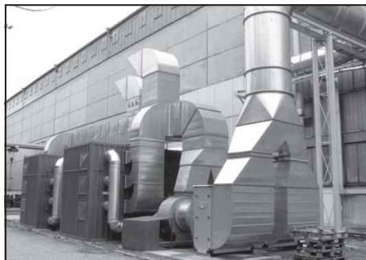
Filtračné jednotky pre lakovňu pri H4. Foto: Archív Žár
