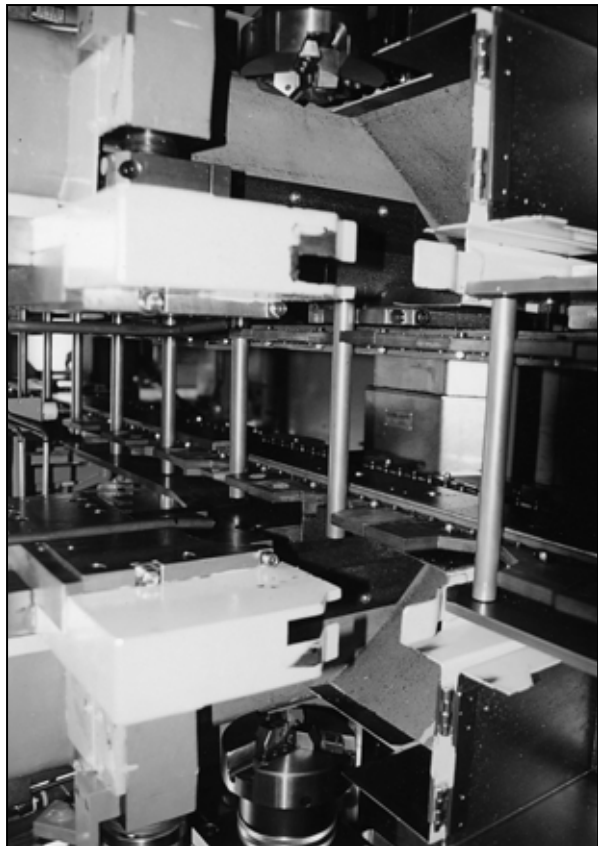
Deliace centrum REIKA – pohľad na priečny dopravník – opravovanie koncov rúr. F: I. Kardhordová
