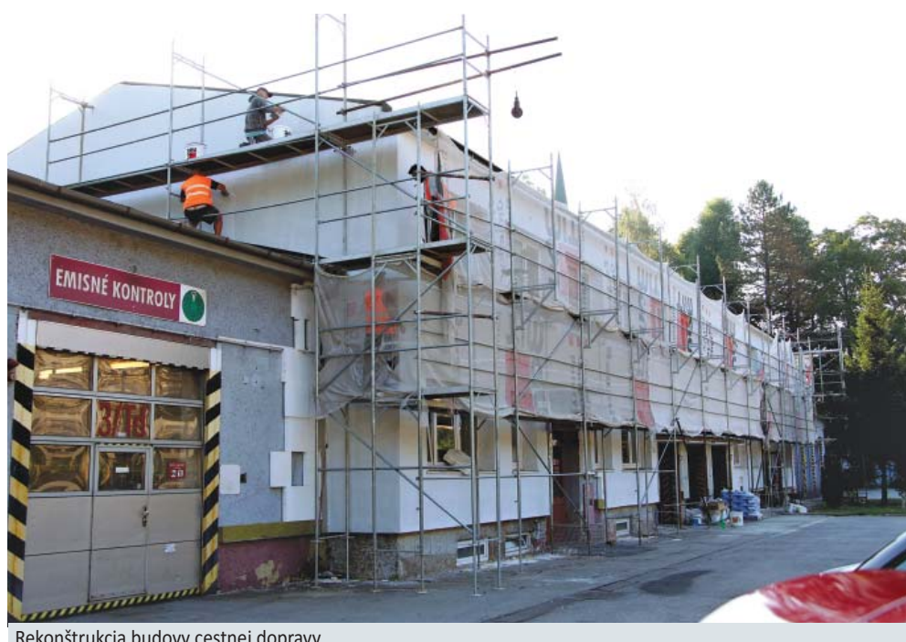
Rekonštrukcia budovy cestnej dopravy
