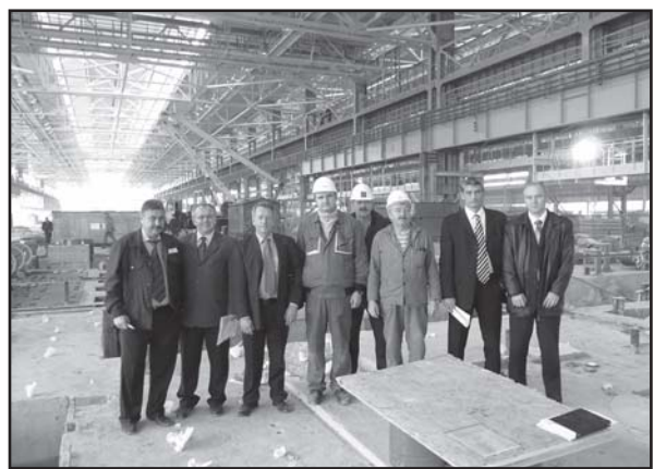
Vedenie akciovej spoločnosti ŽDAS, na čele s generálnym riaditeľom Ing. Miroslavom Šabartom, si v Oskolskom elektrometalurgickom kombináte prezrelo rozpracovanosť haly a oboznámilo sa s podmienkami montáže
