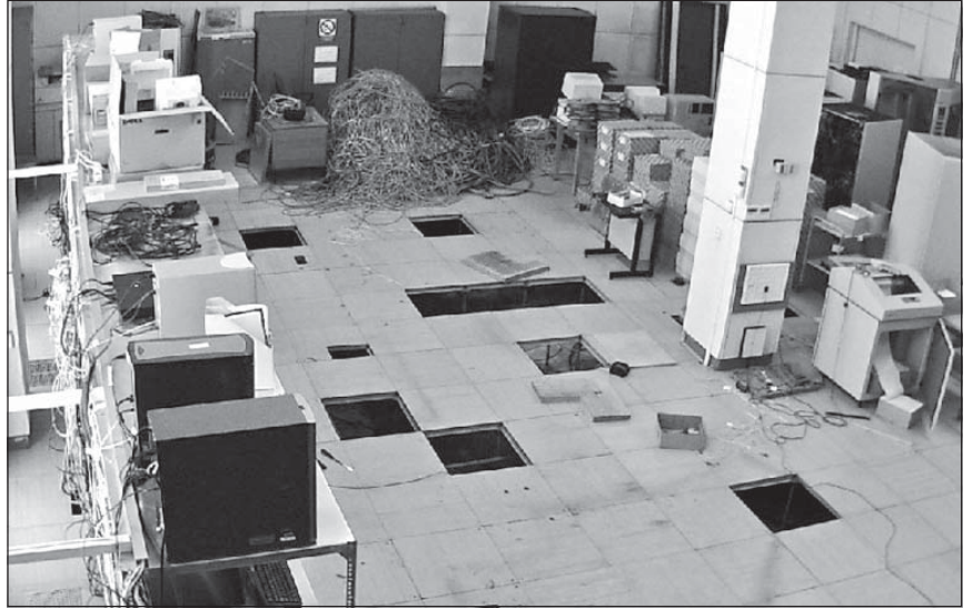
Demontáž mainframe IBM...
