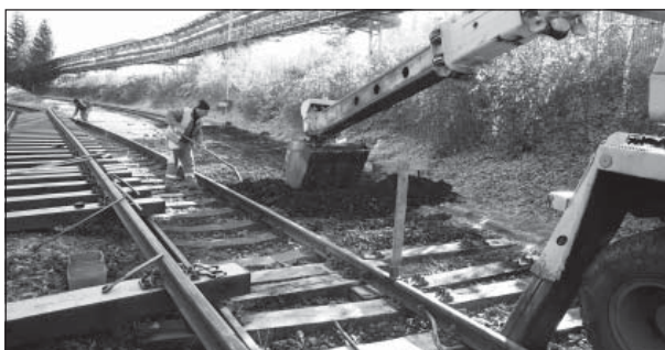
Úsek nad prechodom na Štiavničke v deň výluky
