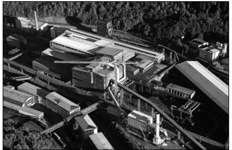
Pohľad na oceliareň pred ukončením rekonštrukcie objektívom A. Nociarovej
