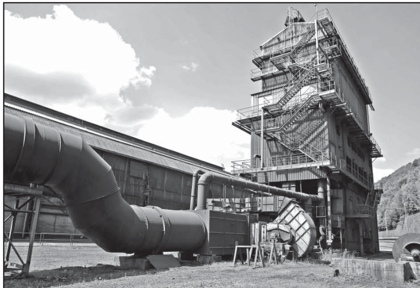
Pohľad na pôvodné zariadenie na odprášenie exhalátov, ktoré slúžilo do roku 2013 aj novej EOP. Foto: A. Nociarová
