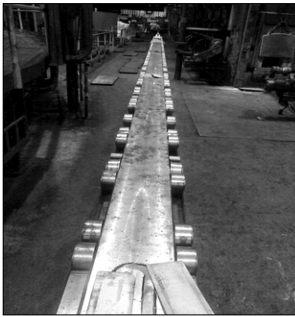
Nová ozubená tyč pretlačovacej stolice, dodávateľ ŽDAS a.s. – pohľad na ustavenie ozubenej tyče pred inštaláciou do pretlačovacej stolice
