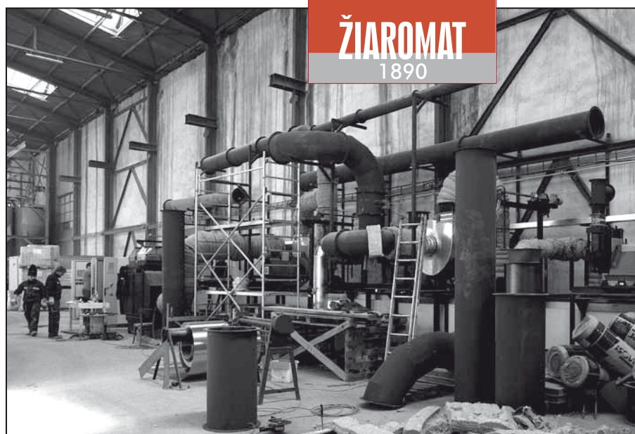
Rozostavaná sušiareň MgO – C stavív.
