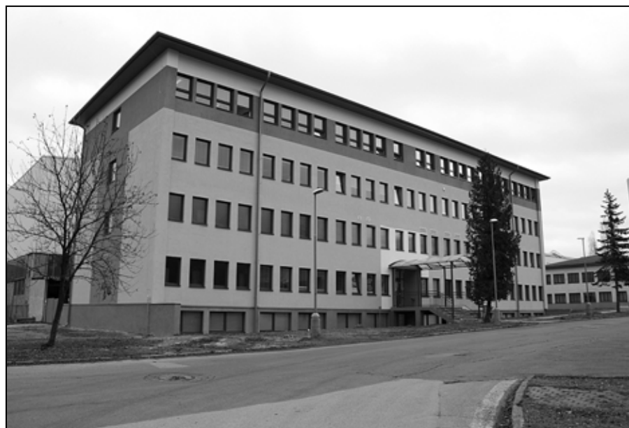
Pohľad na zrekonštruovanú administratívnu budovu valcovne rúr.
