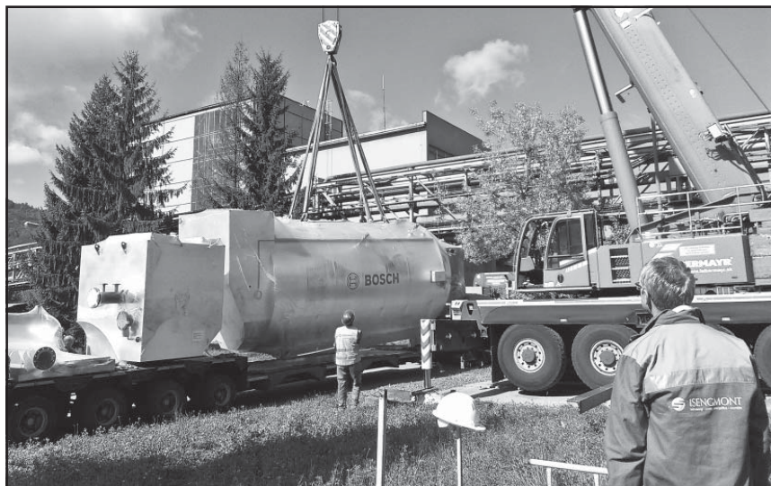
Premiestňovanie kotla pomocou 120 tonového žeriava
