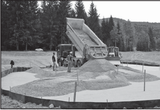
Rozprestieranie pieskového substrátu na jamkovisku č. 6, júl 2013
