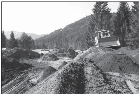
Osievanie zeminy a dočasná skládka na cvičnej ploche, júl 2013
