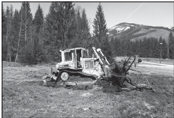
Začiatok prác - kľčovanie pňov, apríl 2013
