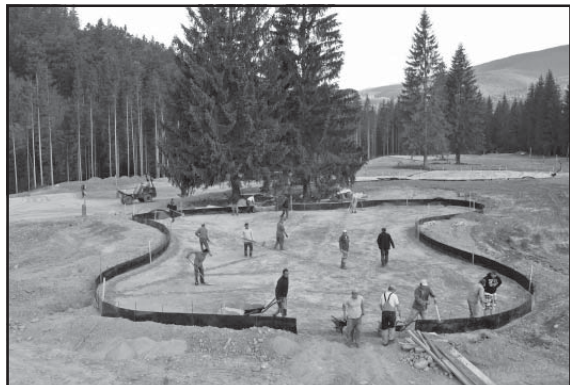
Budovanie systému odvodnenia na jamkovisku č. 9, júl 2013
