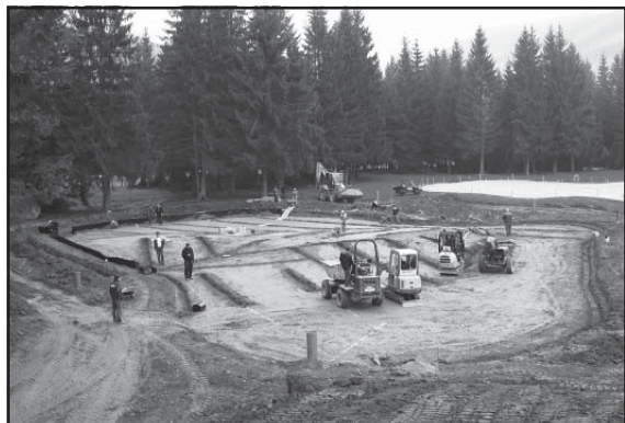
Budovanie posledného cvičného jamkoviska (chipping green), október 2013
