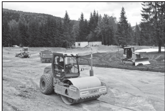
Valcovanie dráh a rozprestieranie preosiatej zeminy, september 2013
