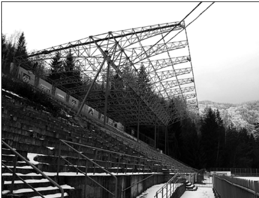
Po demontáži krytiny fixnej strechy - december 2013.
