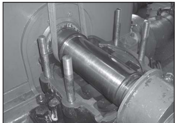
Pohľad na rozobraté ložisko veľkej turbíny v HC Jasenie
